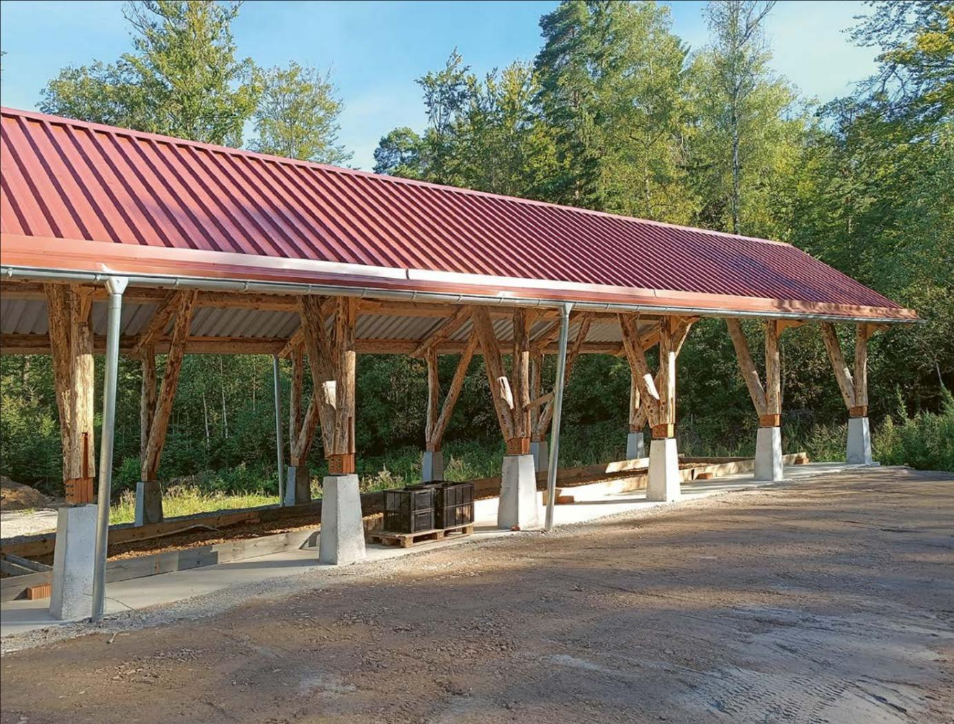
Das Forschungsteam passte die Konstruktion der Lagerhalle – anders als sonst üblich – der Holzbeschaffenheit an. Um eine maximale Tragfähigkeit zu ermöglichen, steht das Hallendach auf nicht angesägten Eichenstämmen. Sie besitzen eine höhere Festigkeit als bearbeitetes Holz.
