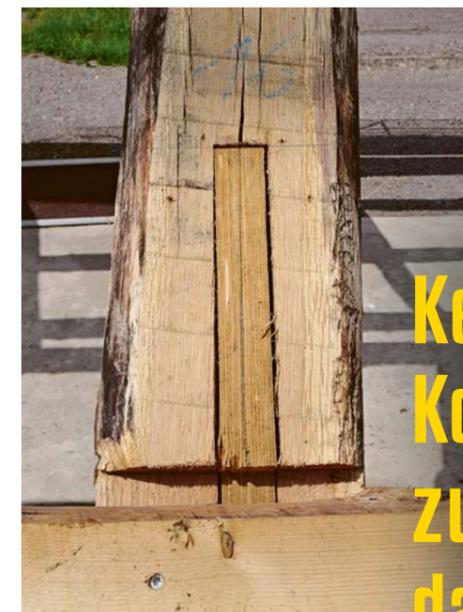
**Keile halten die Konstruktion zusammen – das Eichenholz bleibt unbearbeitet.**
