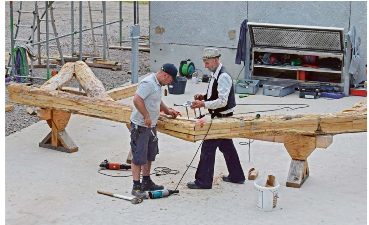
Eine alte Zimmermannstechnik aus England, das sogenannte Green Oak Building, ermöglicht eine stabile Konstruktion. Dabei wird unbehandeltes Holz mit Keilen fixiert und anschließend festgeschraubt.
